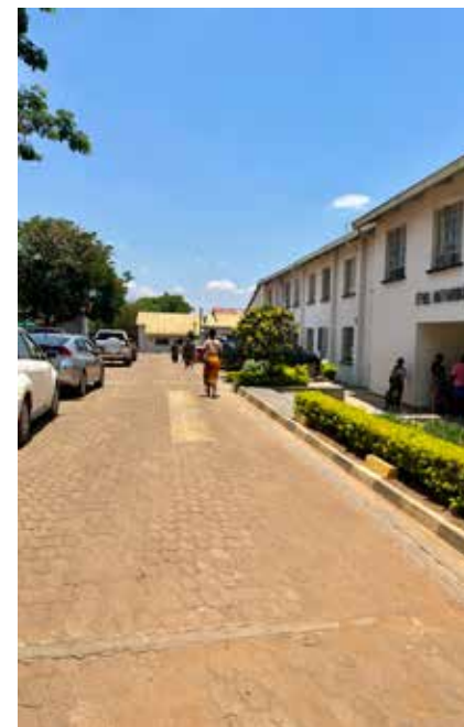
Bilde 2: En del av KCHs Kvinneklivnik til høyre i bildet med poliklinikken og kontorene til overlegene på avdelingen. Lengre nede ligger operasjonsenheten, intensiven, føden, obs-posten, barsel og gynekologisk sengepost.
